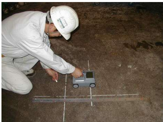
鉄筋の配筋 及び かぶり厚調査
