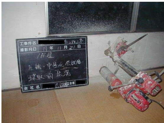
コンクリートコア供試体の採取
