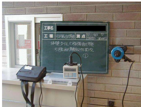
タイルの引張試験
