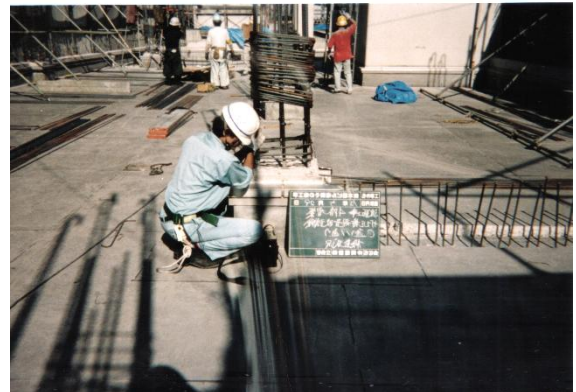
・ ガス圧接部超音波探傷試験
