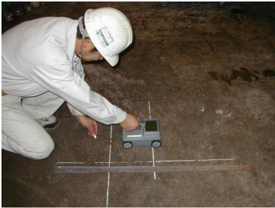
鉄筋の配筋 及び かぶり厚調査
