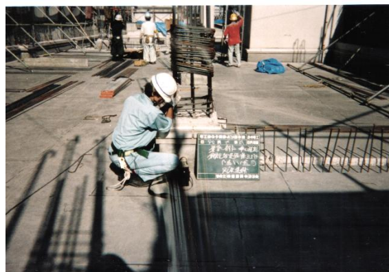
・ ガス圧接部超音波探傷試験
