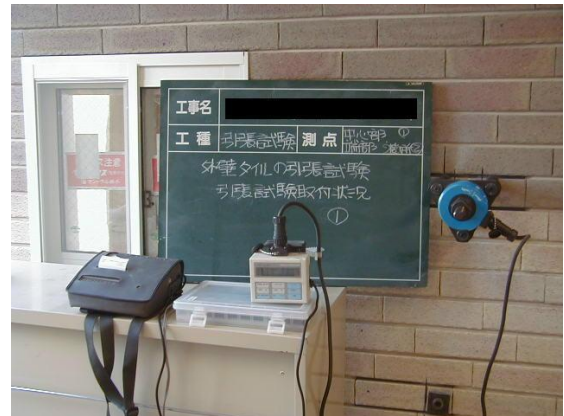
タイルの引張試験
