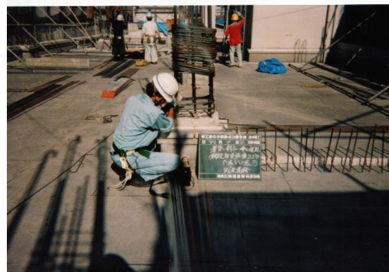
・ ガス圧接部超音波探傷試験
