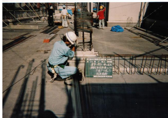
・ ガス圧接部超音波探傷試験
