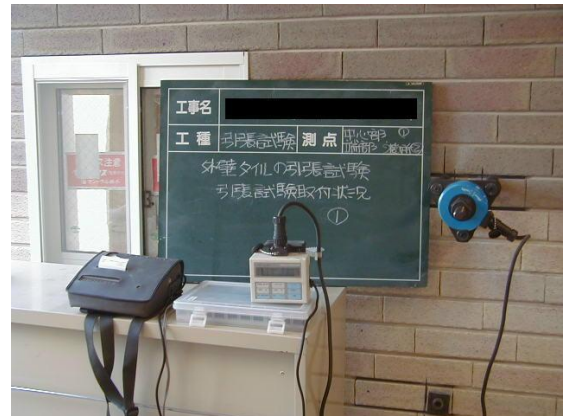
タイルの引張試験
