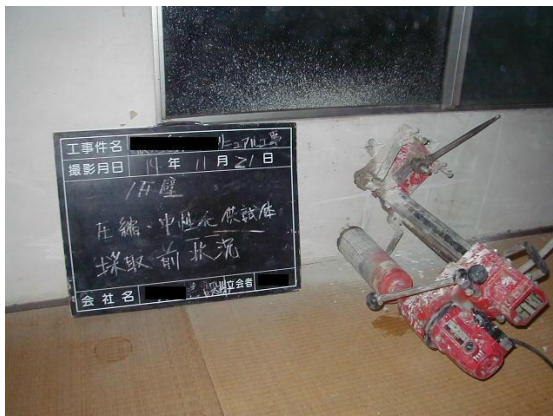
コンクリートコア供試体の採取
