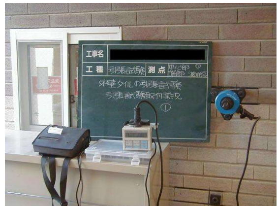
タイルの引張試験
