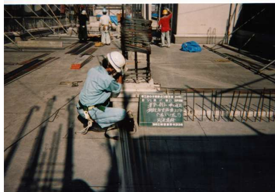
・ ガス圧接部超音波探傷試験
