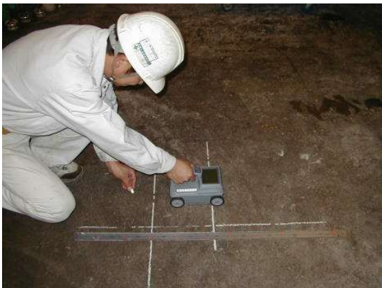
鉄筋の配筋 及び かぶり厚調査
