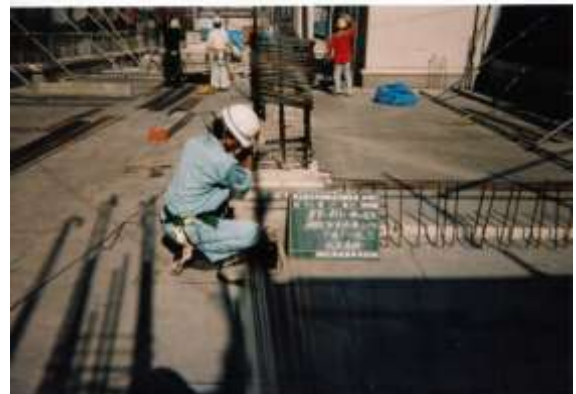
・ ガス圧接部超音波探傷試験
