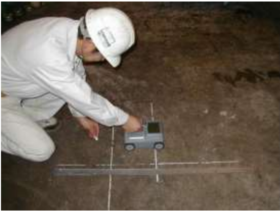
鉄筋の配筋 及び かぶり厚調査
