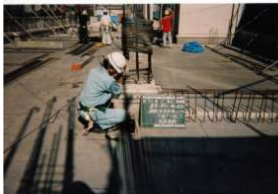
・ ガス圧接部超音波探傷試験
