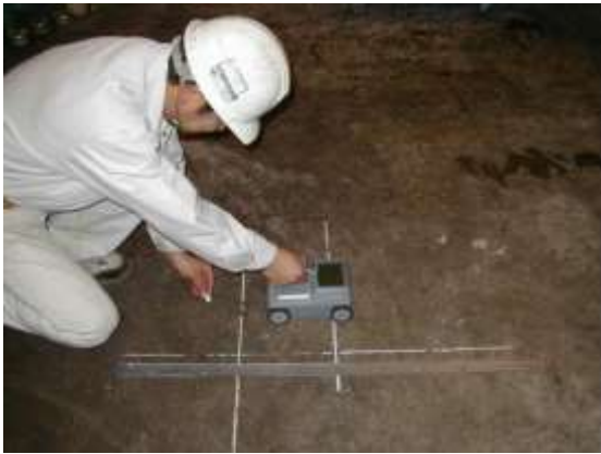
鉄筋の配筋 及び かぶり厚調査
