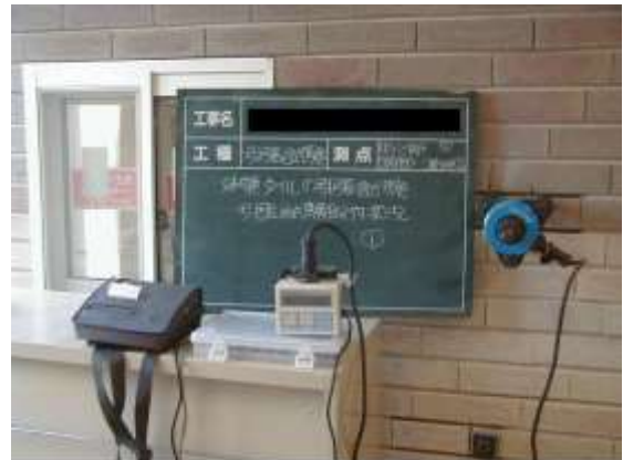
タイルの引張試験
